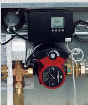
Рис. Блок управления для регулирования температуры воды в подающей трубе в зависимости от температуры наружного воздуха с энергосберегающим циркуляционным насосом со встроенным электронным устройством согласования мощности.
